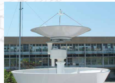
1991 Dartcom-Rotor TYPE AR/AE 1021 verbaut in einem Radom
